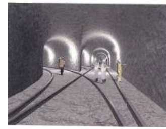
地下施設（地下坑道）
